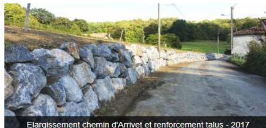
Elargissement chemin d'Arrivet et renforcement talus - 2017
