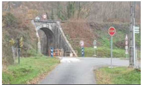
travaux Conseil Départemental
