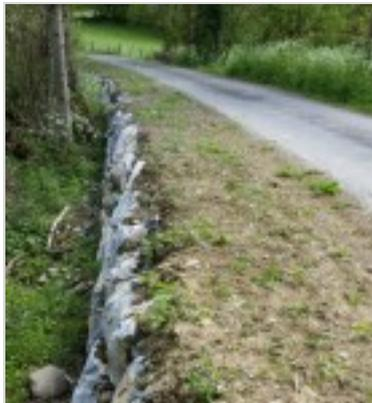
**enrochement d'un talus** chemin de la Passade vers Labroquère réalisé par le SIVOM du Haut-Comminges.
